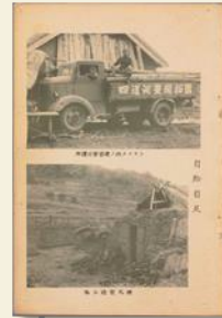
↑トラック班運搬作業↓
